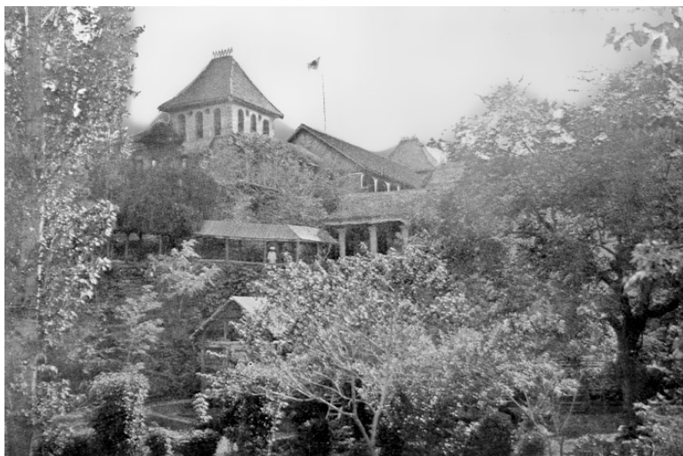
Фото 55. Больница миссии. Центральная башня.
